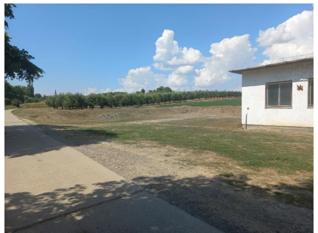
Hanton a vízmű területe megtisztítva az építési törmeléktől
